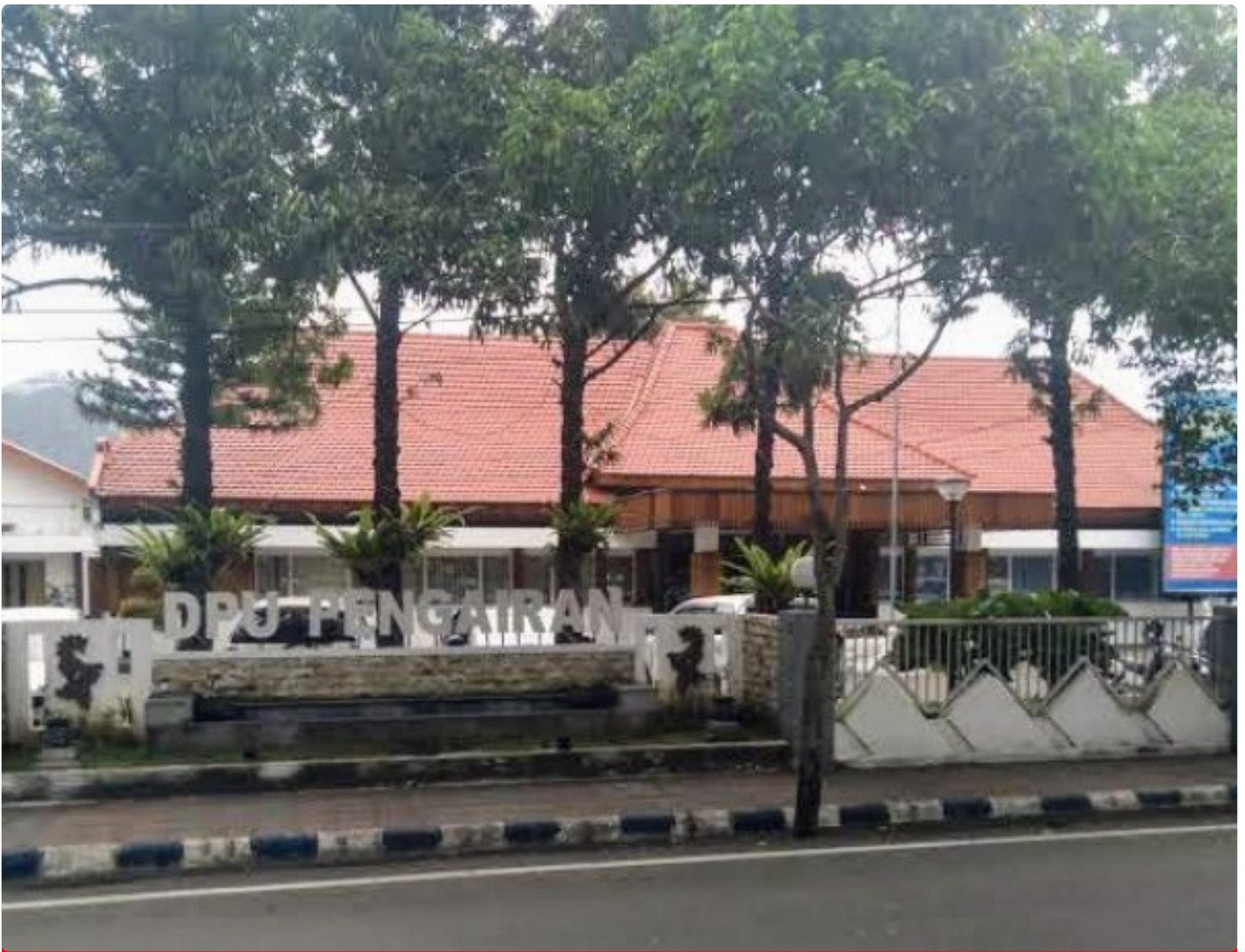
Kantor Dinas Pekerjaan Umum (DPU) Pengairan Kabupaten Banyuwangi
